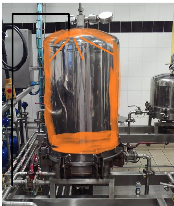
Figure 27 : circuit de l'alcool par la méthode arrivée de l'alcool par le haut de cloche [4]
