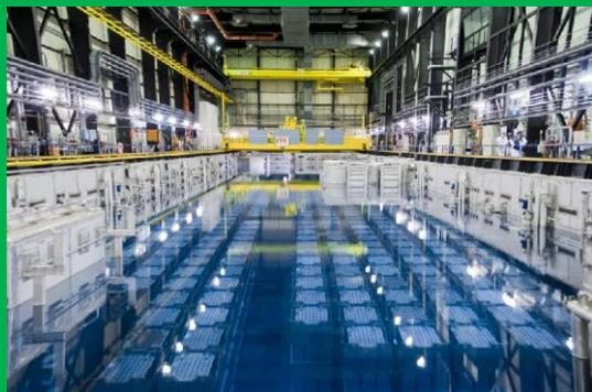
Figure 8 : Piscine d'entreposage des combustibles usés (source : intranet AREVA NC - établissement de la Hague)
