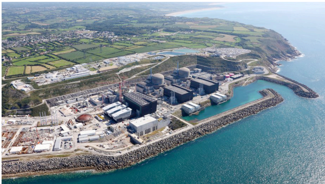
Figure 18 Vue aérienne de Flamanville 1-2 et Flamanville 3 [8]
