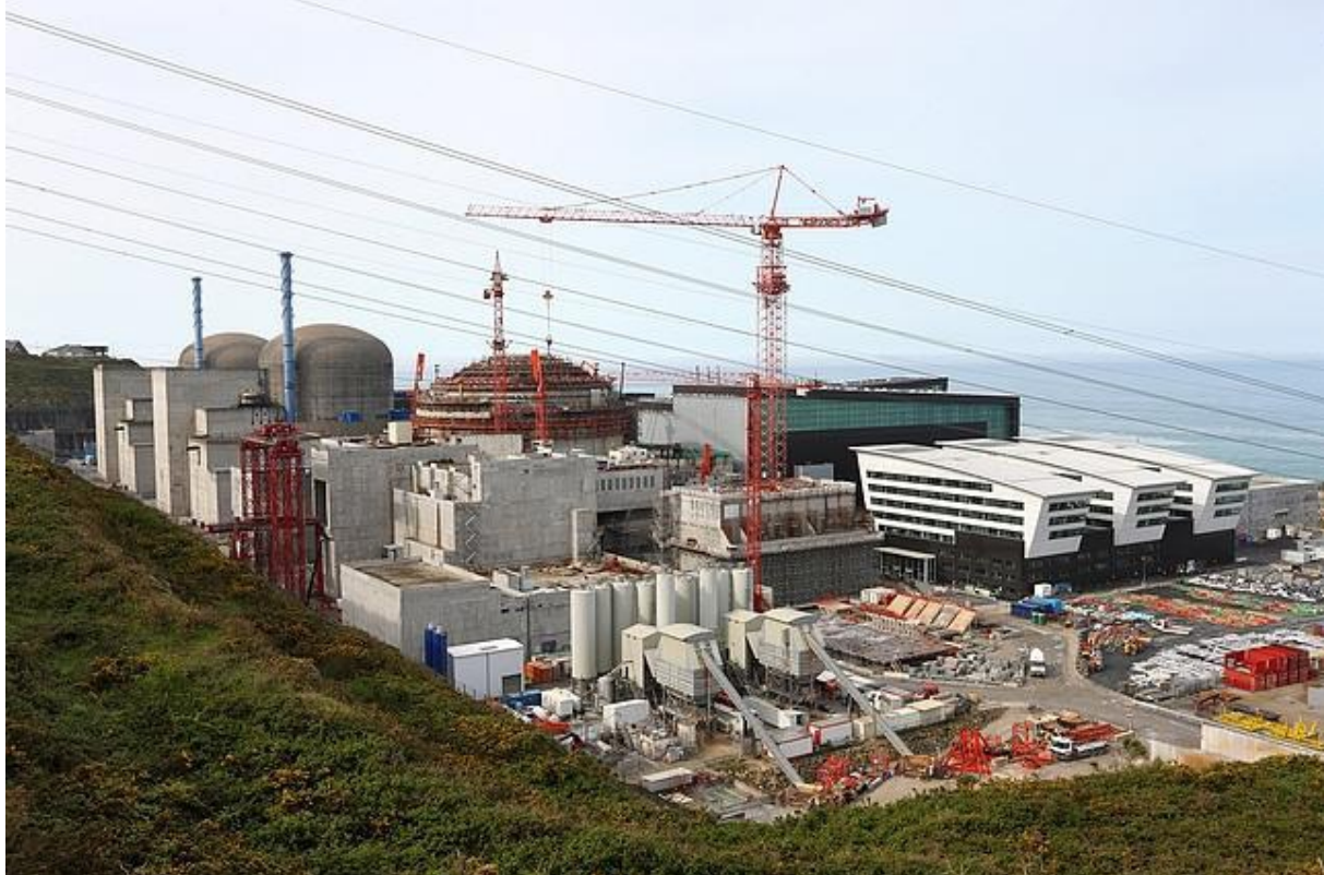
Figure 6 Vue générale du chantier de Flamanville 3 en avril 2014 [8]
