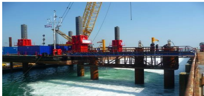
Figure 4 : Opérations de constructions maritimes [7]
