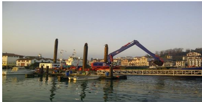
Figure 3 : Opération de dragage [6]
