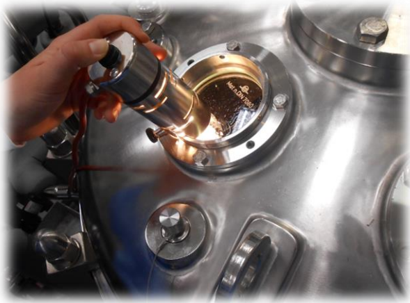
Figure 14 Exemple de photo prise en zone, éclairage d'un bioréacteur, [source auteur].
