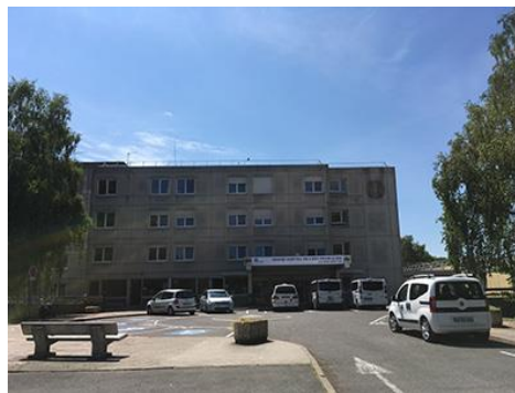
Figure 5 : Site de Coulommiers
