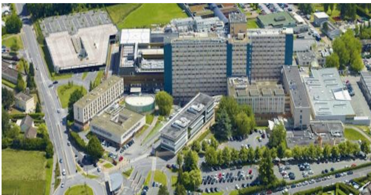
Figure 2 : Centre Hospitalier de Saint-Quentin
