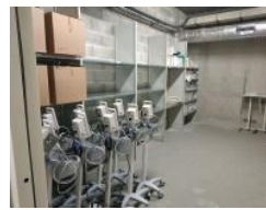
Local de stockage TG HQ 3
