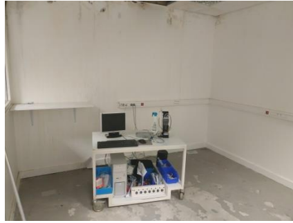
Figure 20 : Future local de stockage pièces détachées
