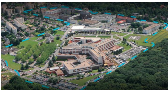
Figure 1:Hôpital de Beauvais (source CHB)
