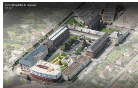
Figure 2:hôpital de Beauvais (source CHB)
